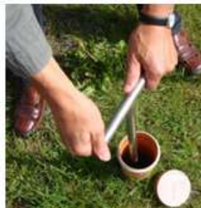
Abbildung 84: Diese Absperrarmatur gibt die Befeuchtung vom Hochbehälter frei
