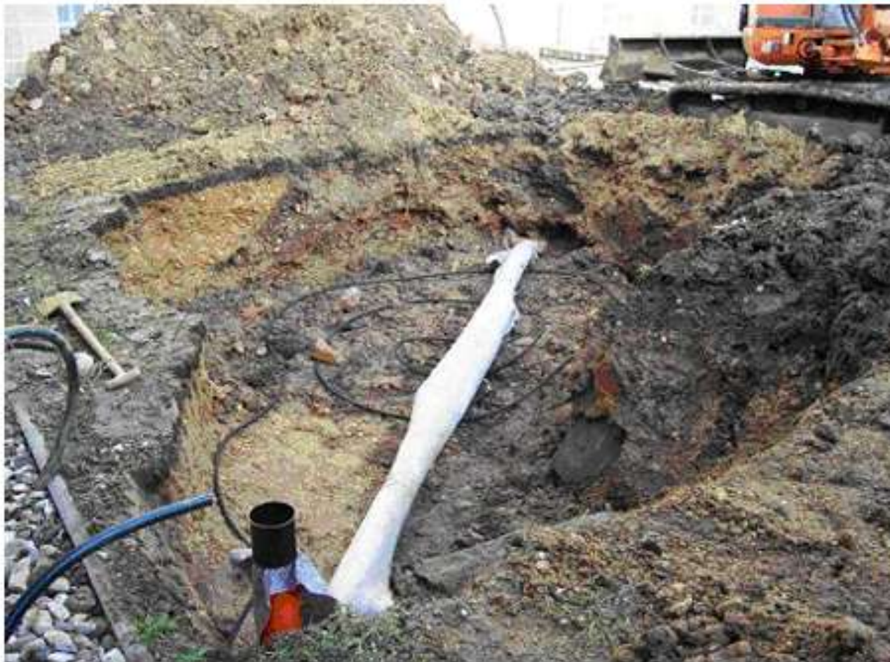
Bild 13: Einbau des Bewässerungssystem Drainagerohr mit Vlies und alternativ das Aquaspa Rohrsystem
