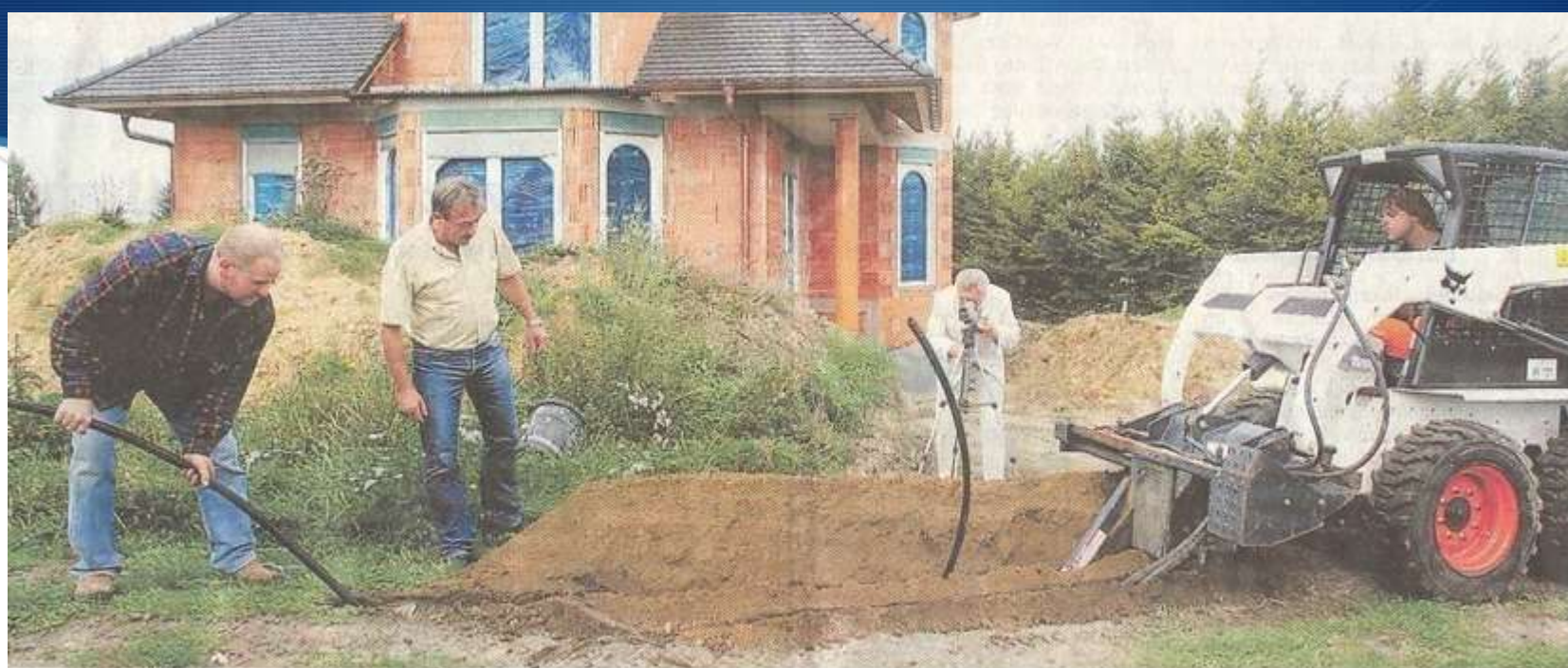
Kollektorenverlegung per Grabenfräse: Michael Walter, Gerd Lohmann, Lothar Lindner (mit Kamera) und im Bagger Dirk Hecht beim Bad Lausicker Pilotversuch. Foto: Jens Paul Taubert
