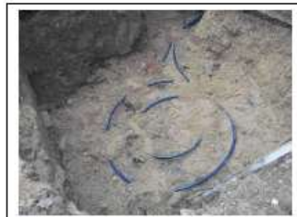
Bild 11: Verlegungen des Kollektors 2008 war die Verlegung aufgrund der niedrigen Außen-Temperaturen nur als Spirale möglich
